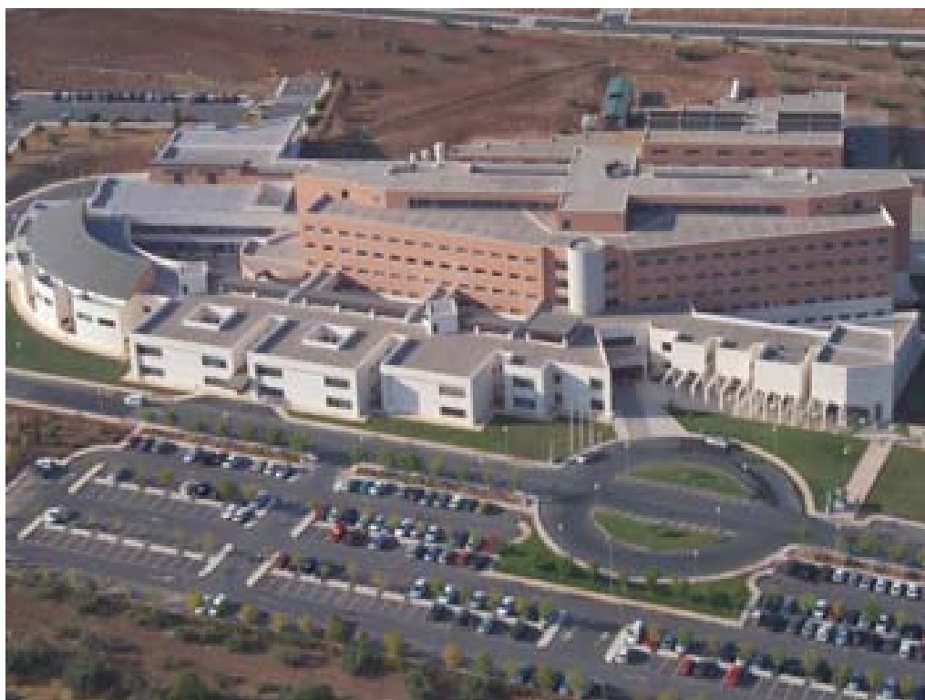
Foto aérea del complejo hospitalario de Antequera.
